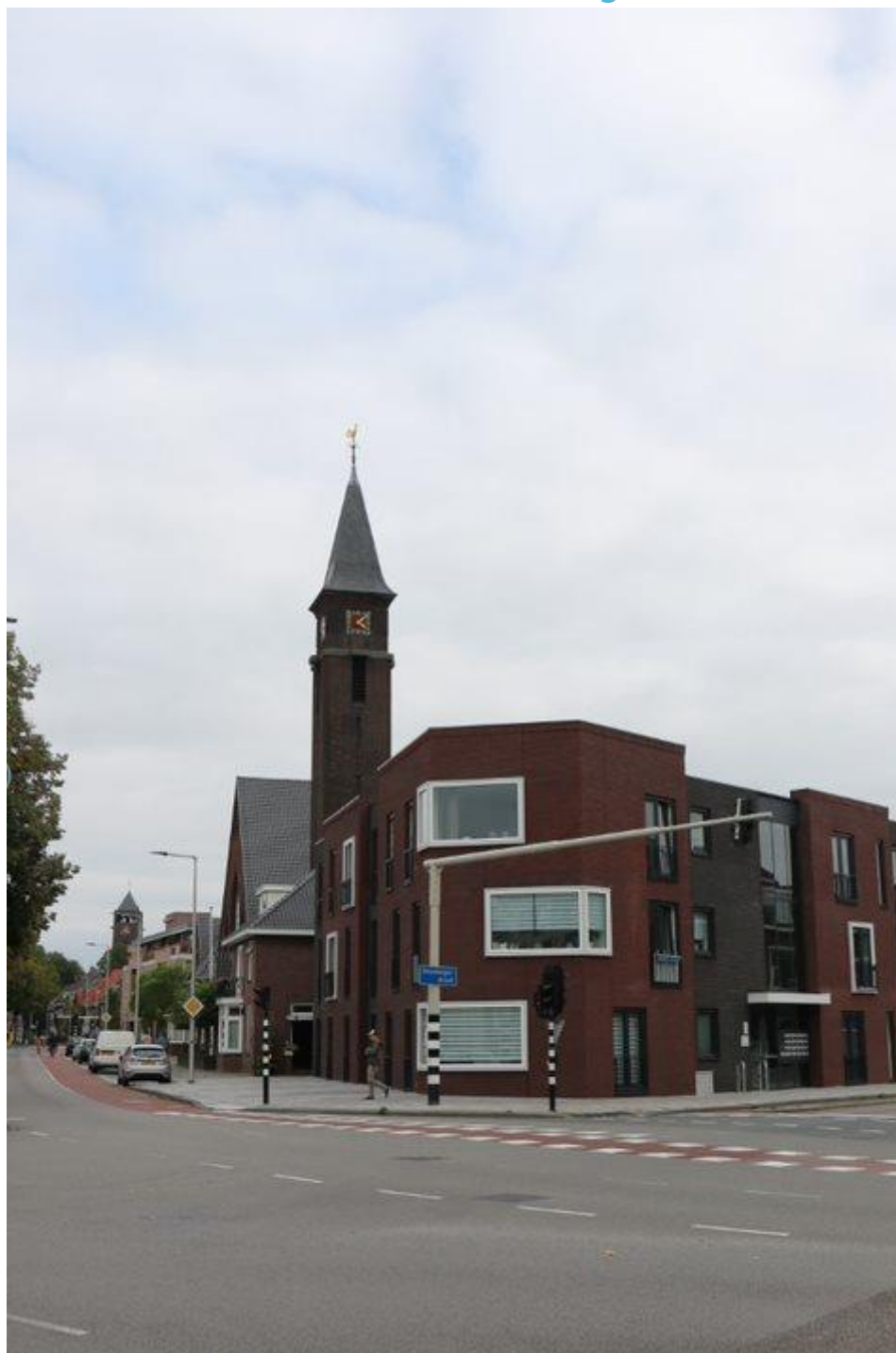
Nieuwbouw Lasonderdriehoek Enschede, 21 tweekamerappartementen
